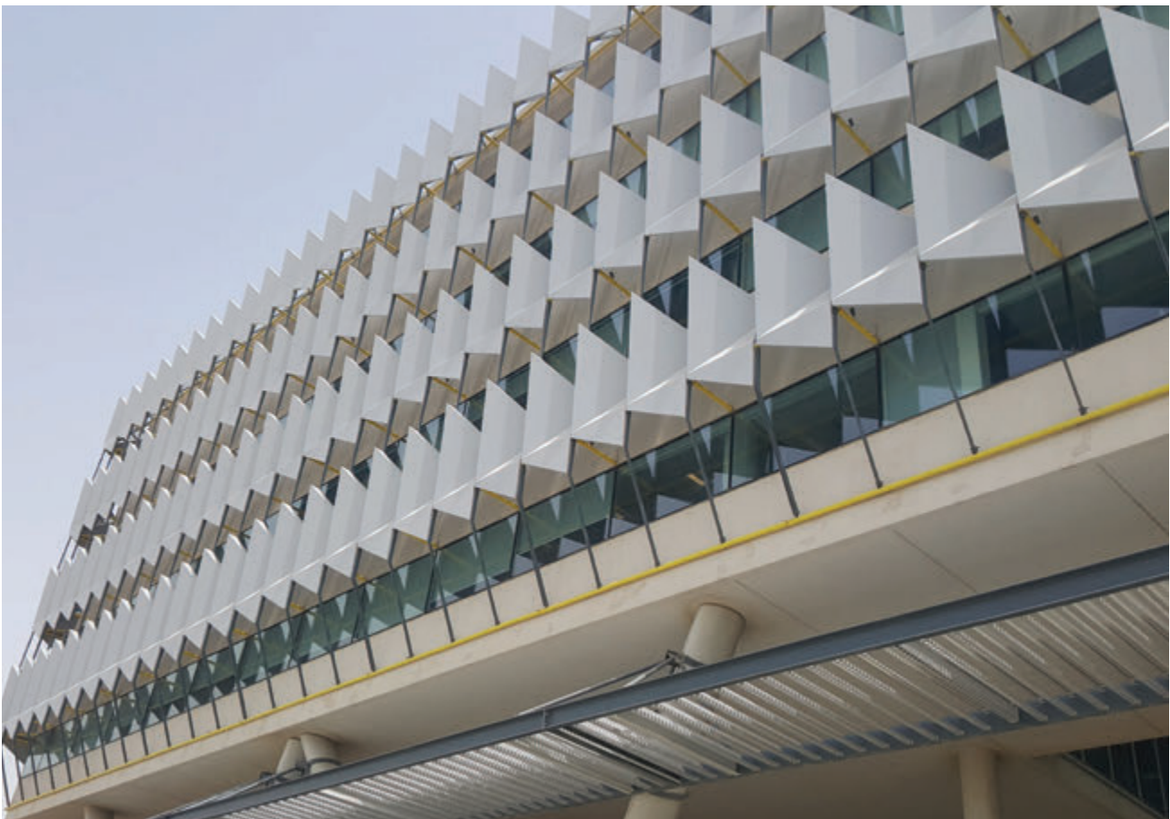
Photo 1-171 Protection solaire en façade des laboratoires par l'extérieur par des éléments textiles. Crédit: NF&A
