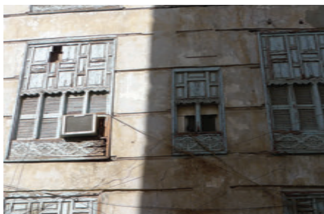
Photo 1-33 Façades avec protection en bois extérieur pour assurer la ventilation des bâtiments. Crédit : FYu
