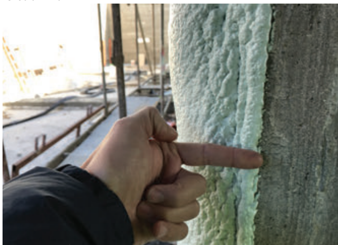
Photo 1-196 Epaisseur du Bio-Polyurethane projeté sur les voiles. Crédit : FYu
