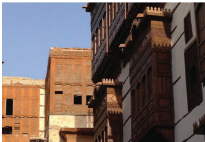
Photo 1-32 Façades avec moucharabieh pour assurer la ventilation des bâtiments. Crédit : FYu
